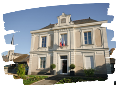
MAIRIE DE BAUNÉ
