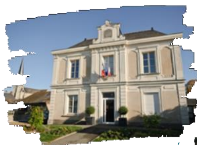
MAIRIE DE BAUNÉ
